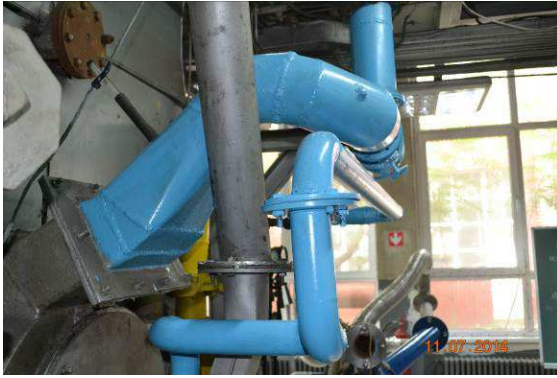
Fig. 4.3. Racordarea noului arzător
