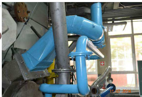
Fig. 3. Arzătorul montat pe cazanul pilot
